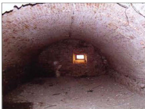
Fig. 4. Boltile compartimentului A al pivniței.
