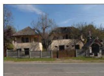
Fig. 22. Tip III. Casa nr. 8, Zona istorică
