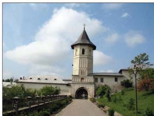
Fig. 9 Mănăstirea Brâncoveni. Accesul
