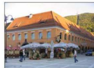
Fig. 15. Foata "Casă a negustorilor", azi restaurantul "Cetbul Carpatin", în Piața Statului 14.
