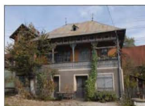
Fig. 21. Tip III. Casa nr. 5, Zona istorică
